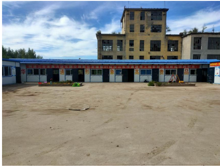
↑ 施工生产生活区
